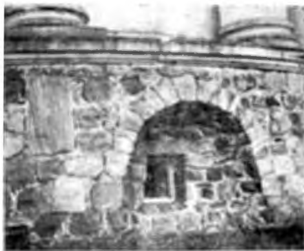
43. Мавзолей в Никольском. Общий вид. Часть цокольного этажа
