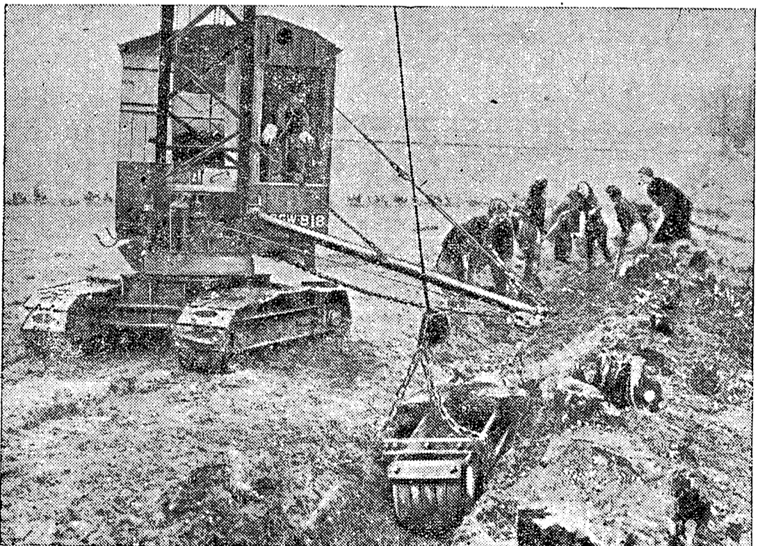
Девушки Женской земледельческой армии с помощью специального экскаватора прокладывают дренажную канаву.
