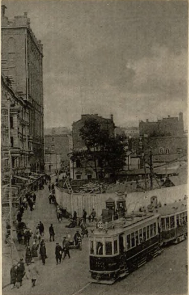
НА МЕСТЕ ЦЕРКВИ СТРОИТСЯ МЕТРОПОЛИТЕН.
