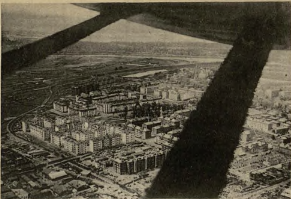
НОВЫЙ РАБОЧИЙ ПОСЕЛОК ДУБРОВКА (вид с аэроплана).
