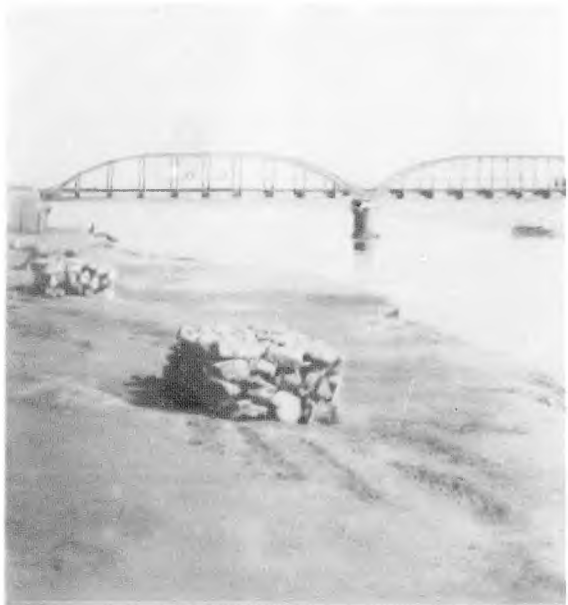
23. Мост в Марката, построенный А. И. Флоренским. Фотография 1880-х годов
