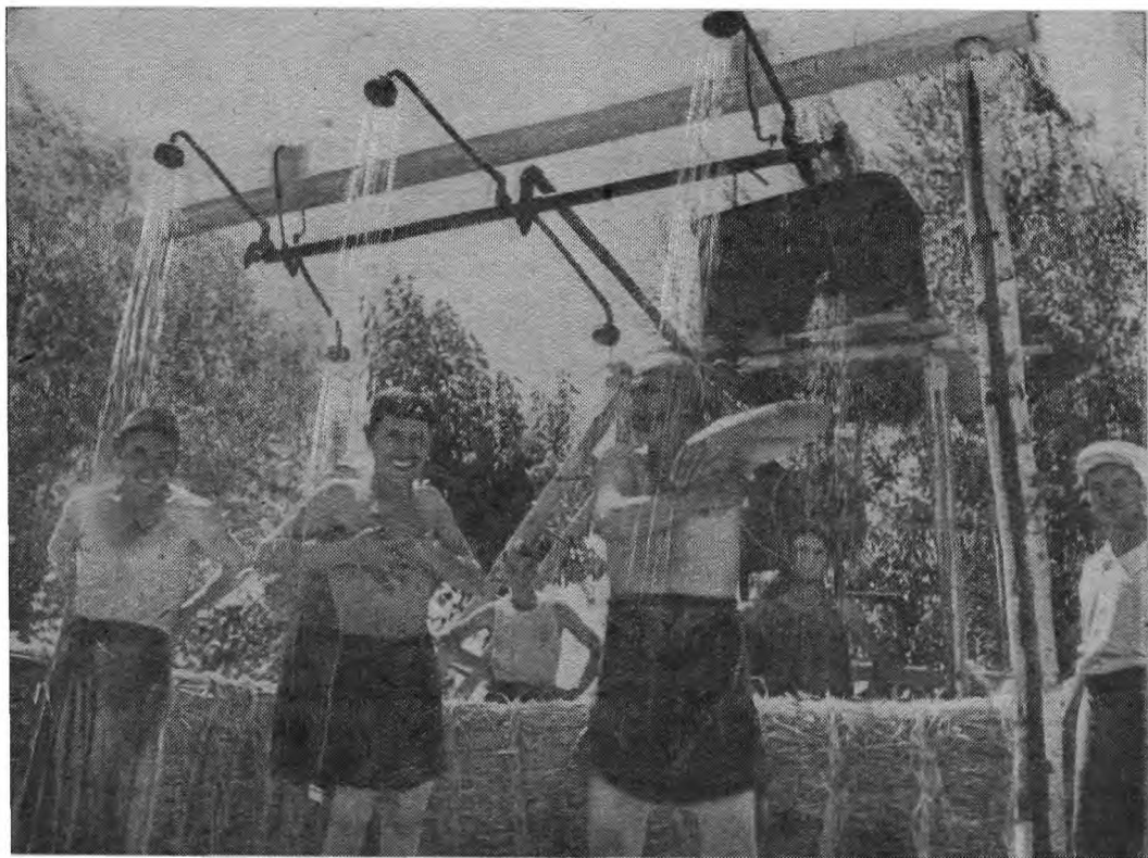
В часы отдыха, перед обедом, колхозники — строители канала — принимали душ. (Фото М. Альперта.)
