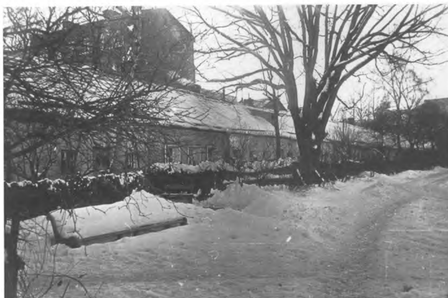
Северо-восточная башня и корпус келий, вид в 1979 г. с бульвара, с северо-запада
