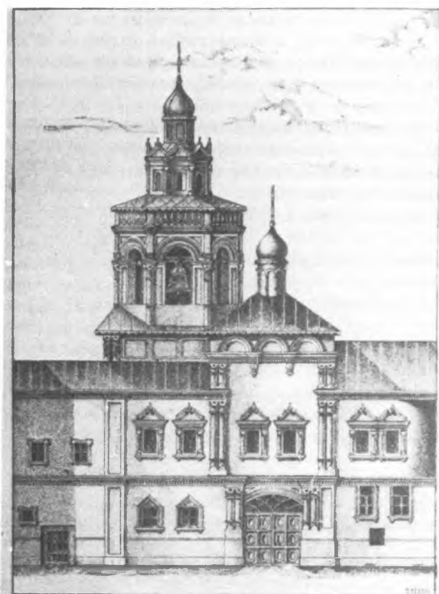
Церковь Михаила Малюина с колокольней, вид с юга 26
