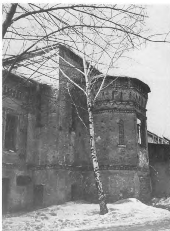
1982 г. Вид обезглавленного храма извне, с юго-востока
