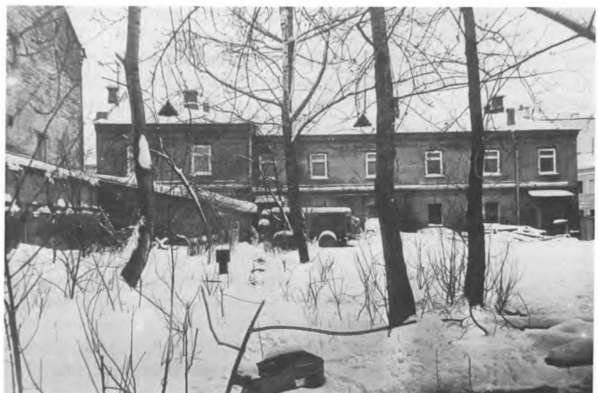
1979 г. Кельи и остатки монастырской стены, вид с востока, от бывшего монастырского двора. На пустыре перед стеною находились (частично) церкви влмк. Никиты и влмк. Димитрия (другая часть на месте нового здания подстанции)
