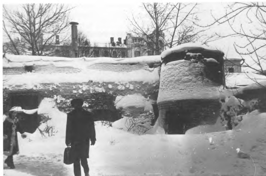
1979 г. Юго-восточная башня
