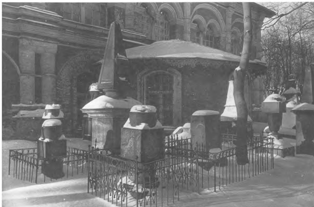
1979 г. Вид с юго-востока абсиды придельного храма Сретения при новом соборе
