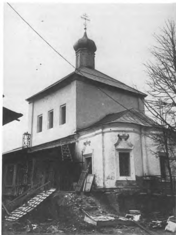
1979 г. Воскресенский собор, вид с юго-востока
