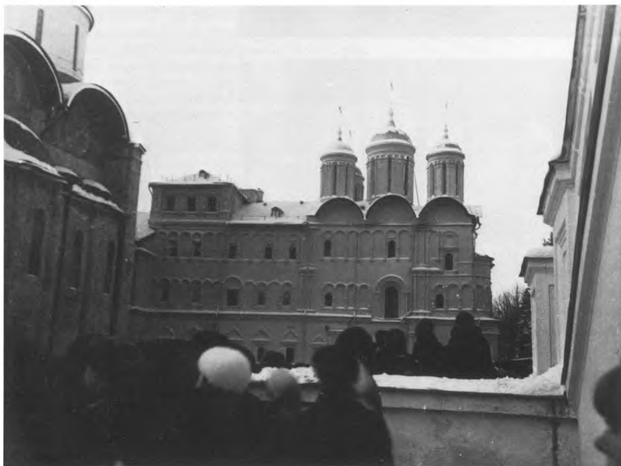
1979 г. Вид церкви Двенадцати апостолов и расположенной над нею церкви ап. Филиппа с юга (дореволюционное фото церкви ап. Филиппа вместе с церковью Двенадцати апостолов см. при предыдущем № 4)
