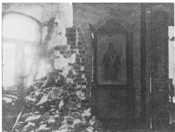
Чудов Монастырь. Снарядом разрушена стена, а св. икона, стоящая у стены, и лампада остались неповрежденными
