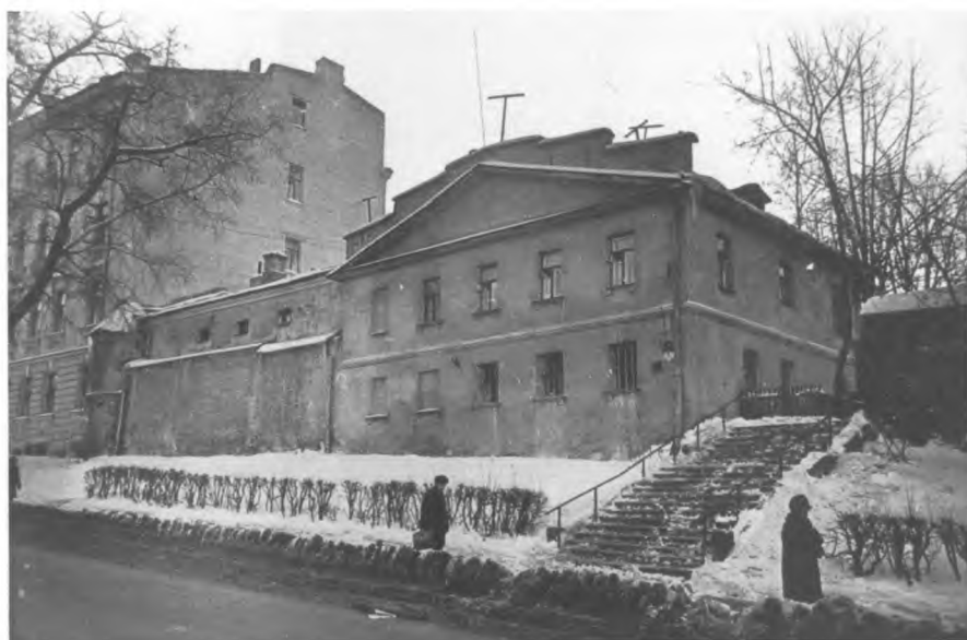
1979 г. Кельи у восточной стены, вид с северо-запада
