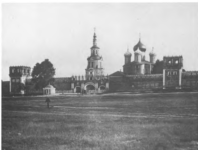
1882 г. Вид Донского монастыря с севера, слева — часовня до перестройки. Альбом Найденова, ч. 4 № 3
