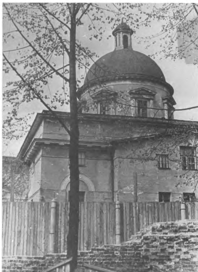
1980 г. Вид церкви Троицы с северо-запада через рухнувший фрагмент стены, замененный дере- вянным забором
