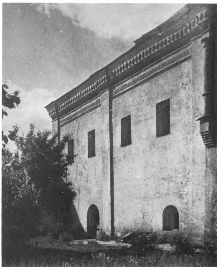
1973 г. Вид трапезной 1504 г. с юга 68
