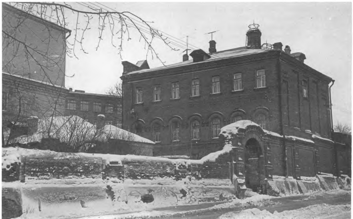
1979 г. Ограда, ворота и кельи по 2-му Зачатьевскому переулку
