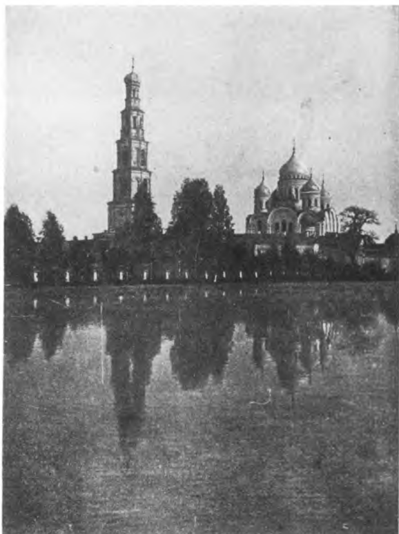
Собор и колокольня, вид в начале XX в. из-за пруда, с северо-востока 85
