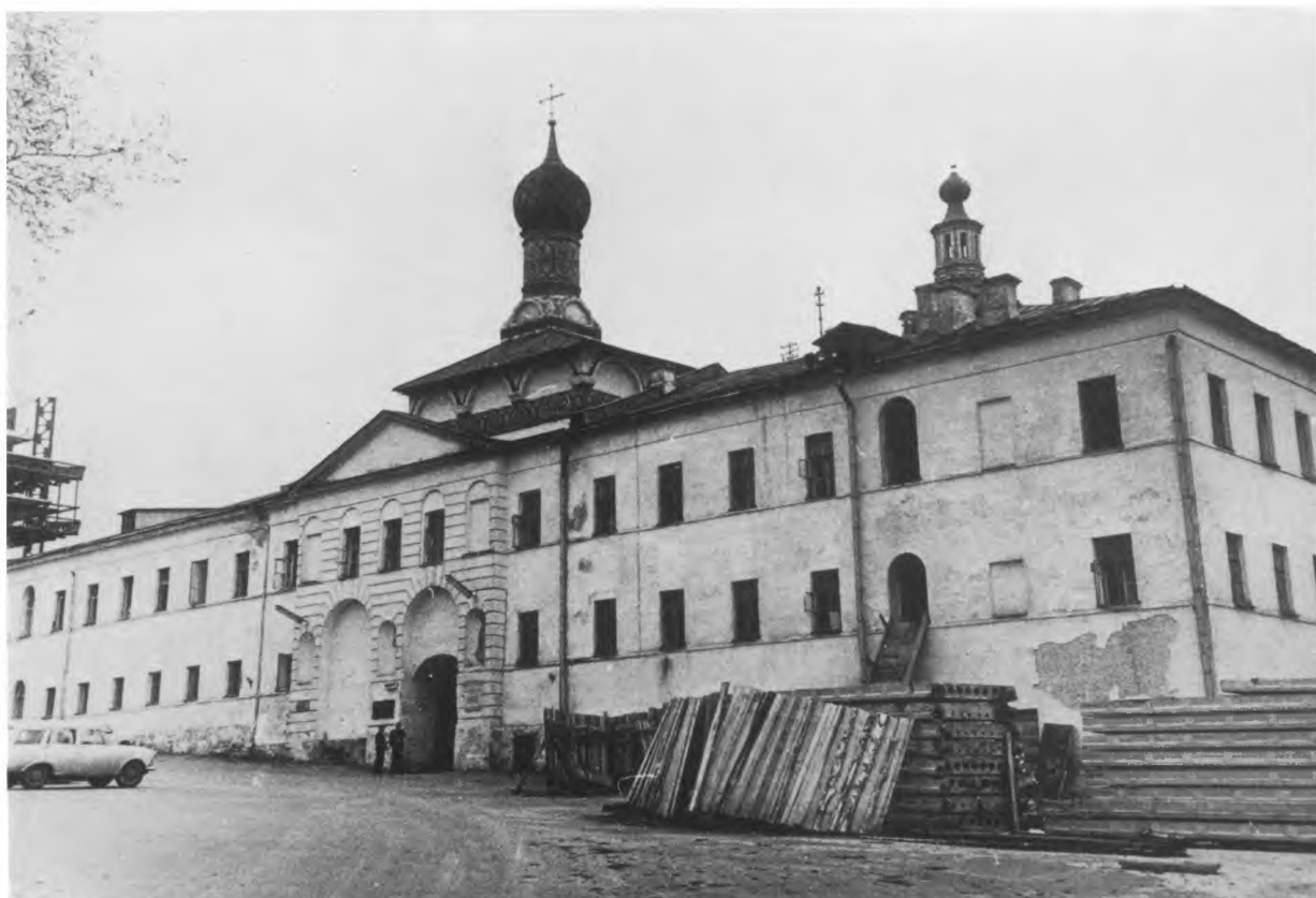
1979 г. Восточный корпус с надвратной церковью Андрея Стратилата, вид с северо-востока
