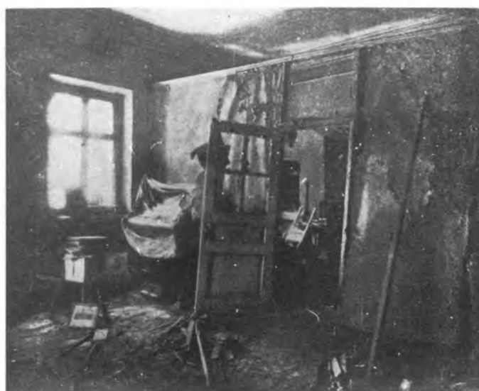
Разрушения в Петровских Палатах
