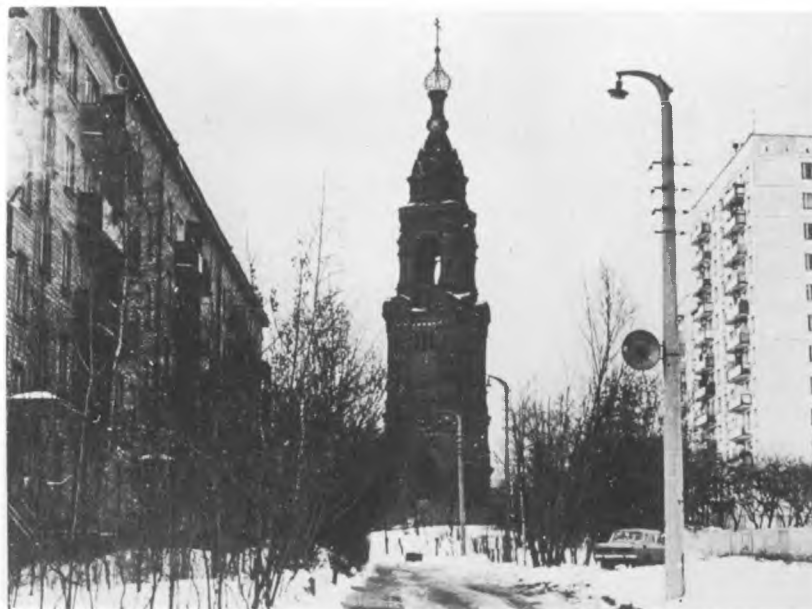
1979 г. Вид колокольни от Кронштадтского бульвара; больничный корпус снесен
