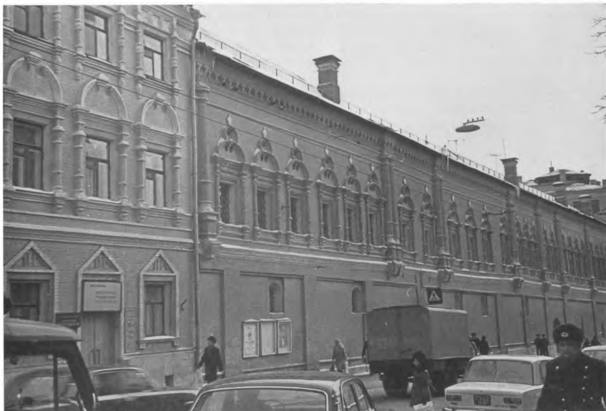
1979 г. Кельи с палатами Нарышкиных (справа) и кельи XIX в. (слева) — вид с ул. Петровка
