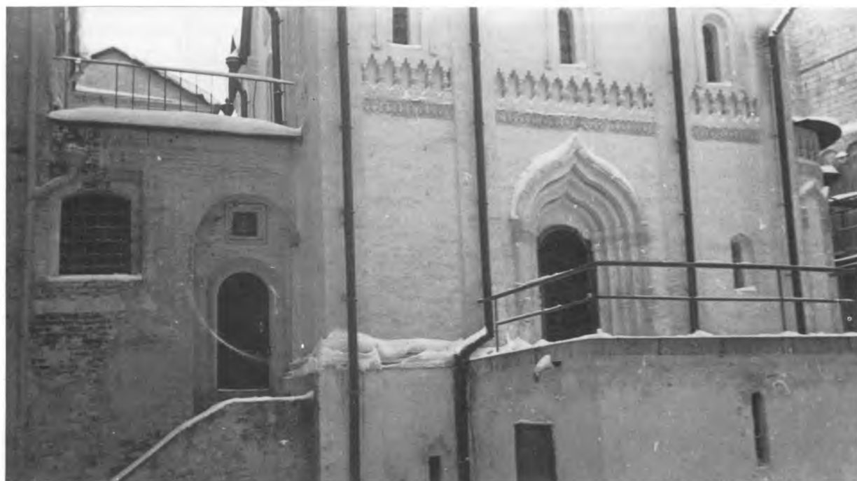
1979 г. Вид с юга на часовенное место: справа — новый вход на месте крыльца часовни, слева — застроенное место часовни
