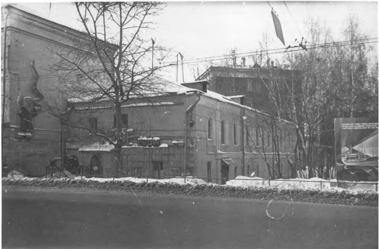
1979 г. Монастырские кельи, ныне бар "Гном", вид с северо-востока
