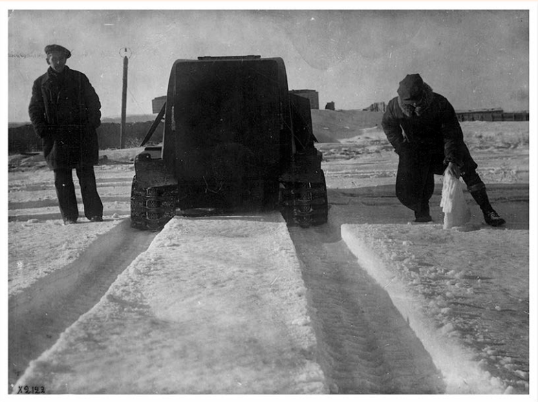
“Бомбардир” на снежной целине с крепким настом. Кусок наста я держу для фотографирования. Слева стоит А.А. Душкевич, не проваливаясь. Гусеницы “Бомбардира” при их значительной длине и ширине размельчили наст и промяли глубокую колею.
