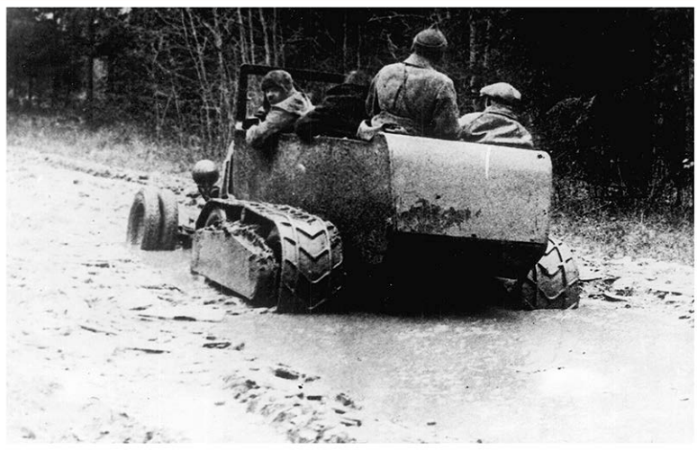
Полугусеничный "вездеход" с фрикционным зацеплением гусениц. За рулём Франц Кароль. В будёновке Азбукин.
