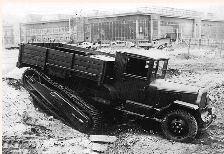
Приспособляемость балансирного гусеничного движителя автомобиля ЗИС-42
