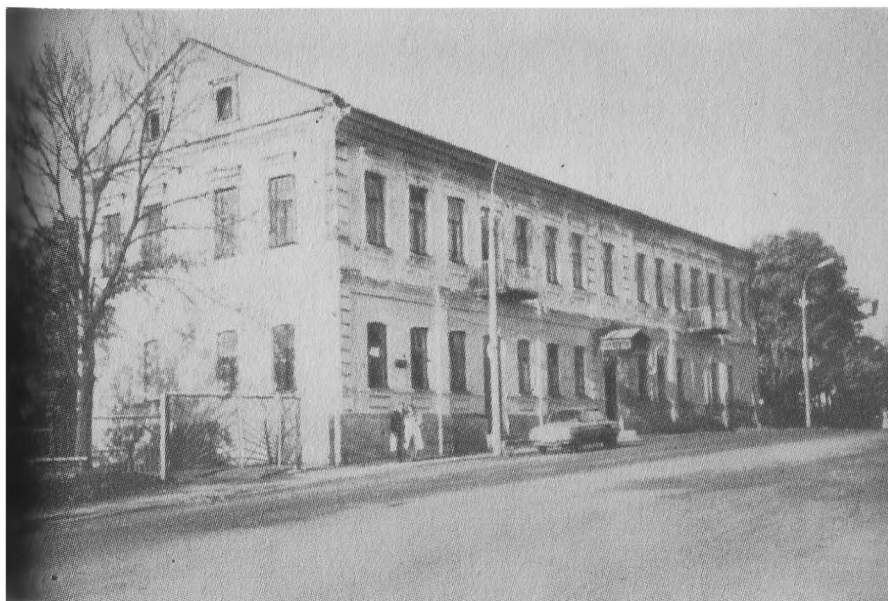
Здание бывшей Невельской гимназии. 27 сентября 1995 г. здесь была открыта мемориальная доска: «В этом здании в 1918–1920 гг. работали философы М.М. Бахтин (1895–1975) и М.И. Каган (1889–1937)». Фотография сделана в день открытия доски
