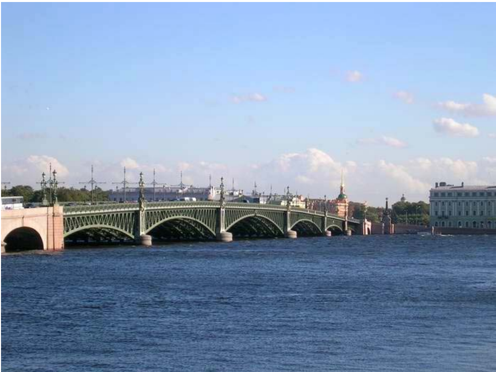
Троицкий мост в С. Петербурге
