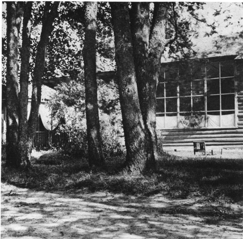
25. Мастерская В. Н. Домогацкого в его имени Адамполь Витебской губернии Пристройка к старому дому. Фотография 1916 г.
