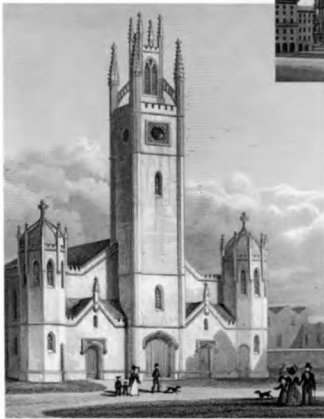
Новая церковь в Хаггерстоне. 1829.
