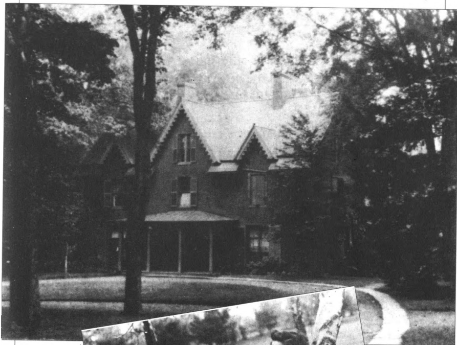
Дом на улице Готорн
