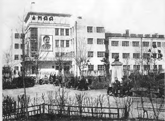
Здание Главпочтамта на ул. Кирова
