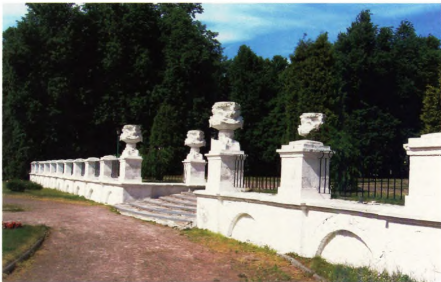
Исторический парк. Подпорная стенка террасы
