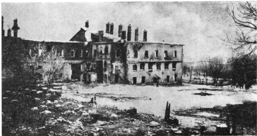
Москва. Декабрь 1905 г. Разрушенная фабрика Шмита. Фото.
