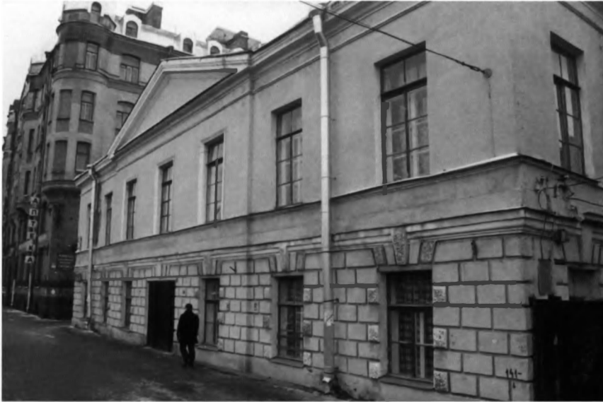
Здание бывшего Андреевского городского мужского четырехклассного училища (ныне детский сад «Андрейка») на углу 7-й линии Васильевского Острова и Днепровского переулка в доме 20/2. Фотография А. Савкина.
