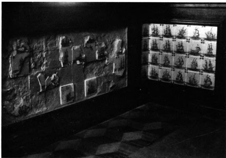
Фрагмент консервированной разбитой панели и восстановленная панель Секретарской Монплезира.
