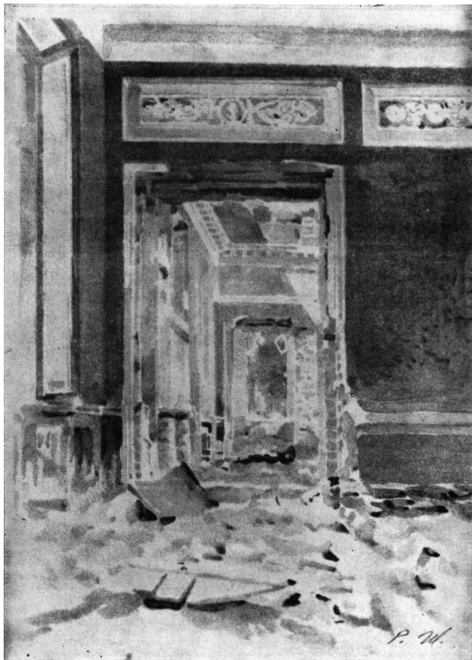
Р. Ф. Житков. Разрушенный интерьер Екатерининского корпуса Монплезира. Цветная литография. 1944.
