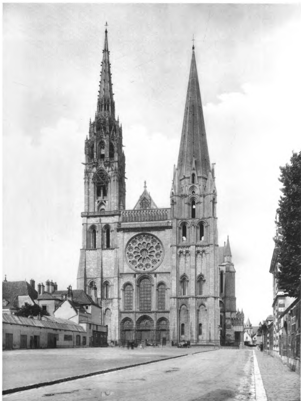
31. Шартрский собор. Западный фасад
