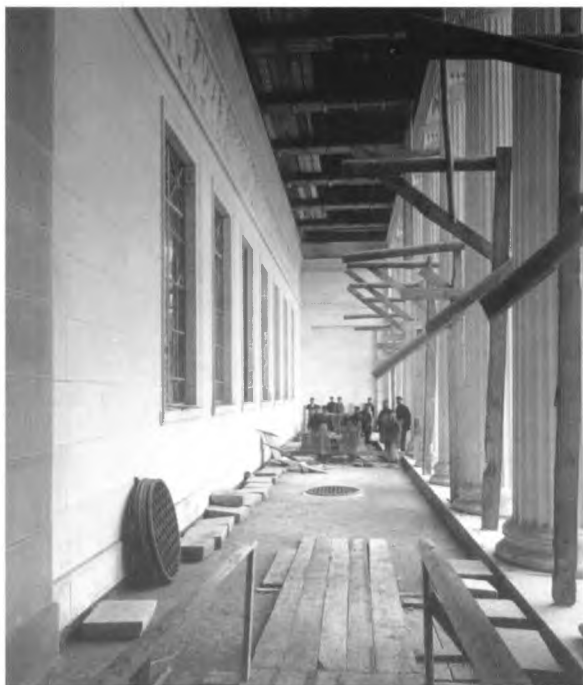
104. Настилка гранитных полов и установка иллюминаторов на внешней колоннаде Музея. Вторая половина 1905 г.
