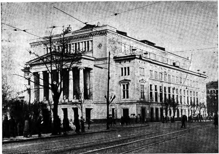
Здание городского театра в Риге. Архитектор Л. Бонштедт. 1860—1863 гг.
