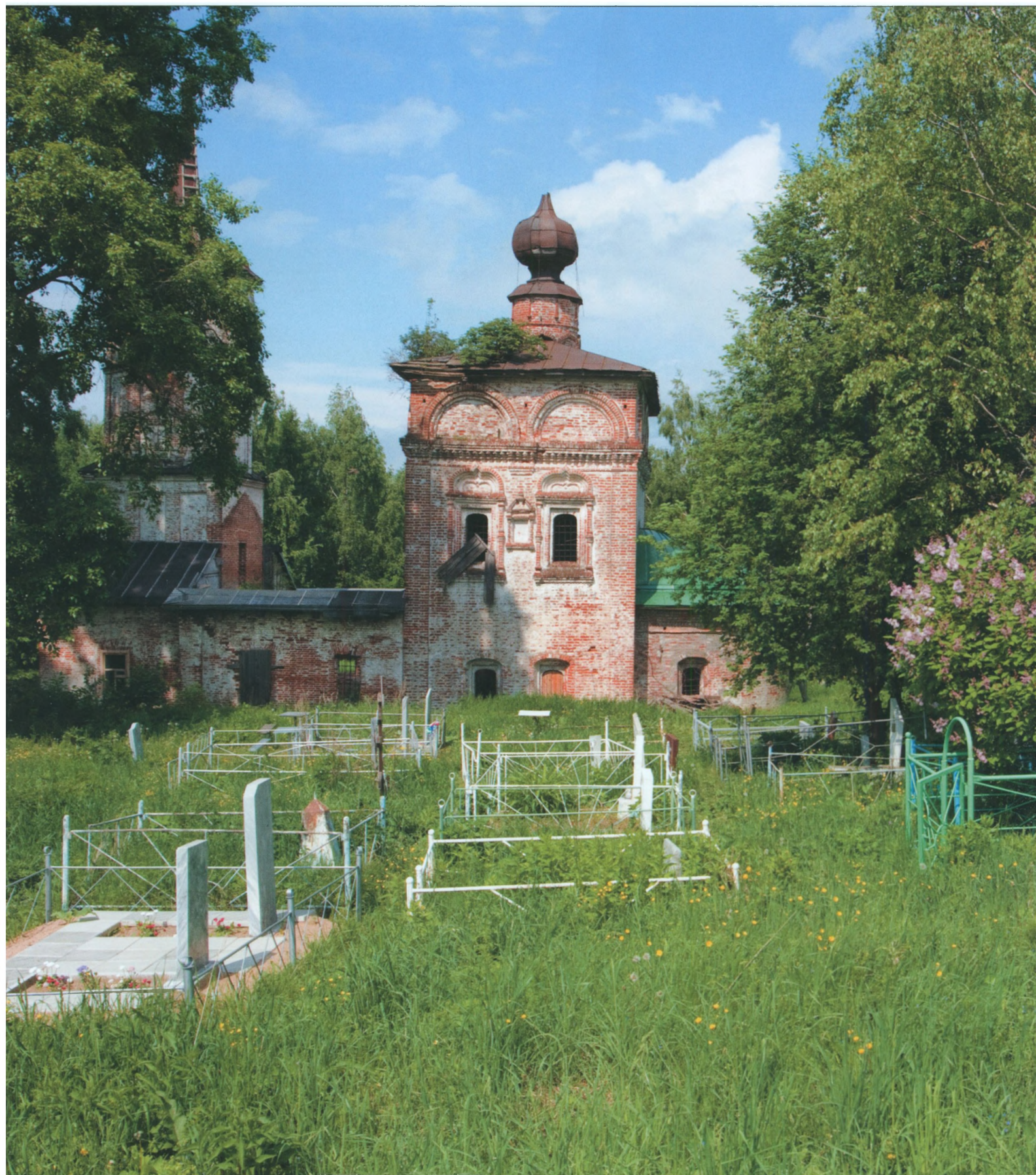
[73] Пыскор. Никольская церковь, вид с юга. Pyskor. Church of Saint Nicholas, south view.
