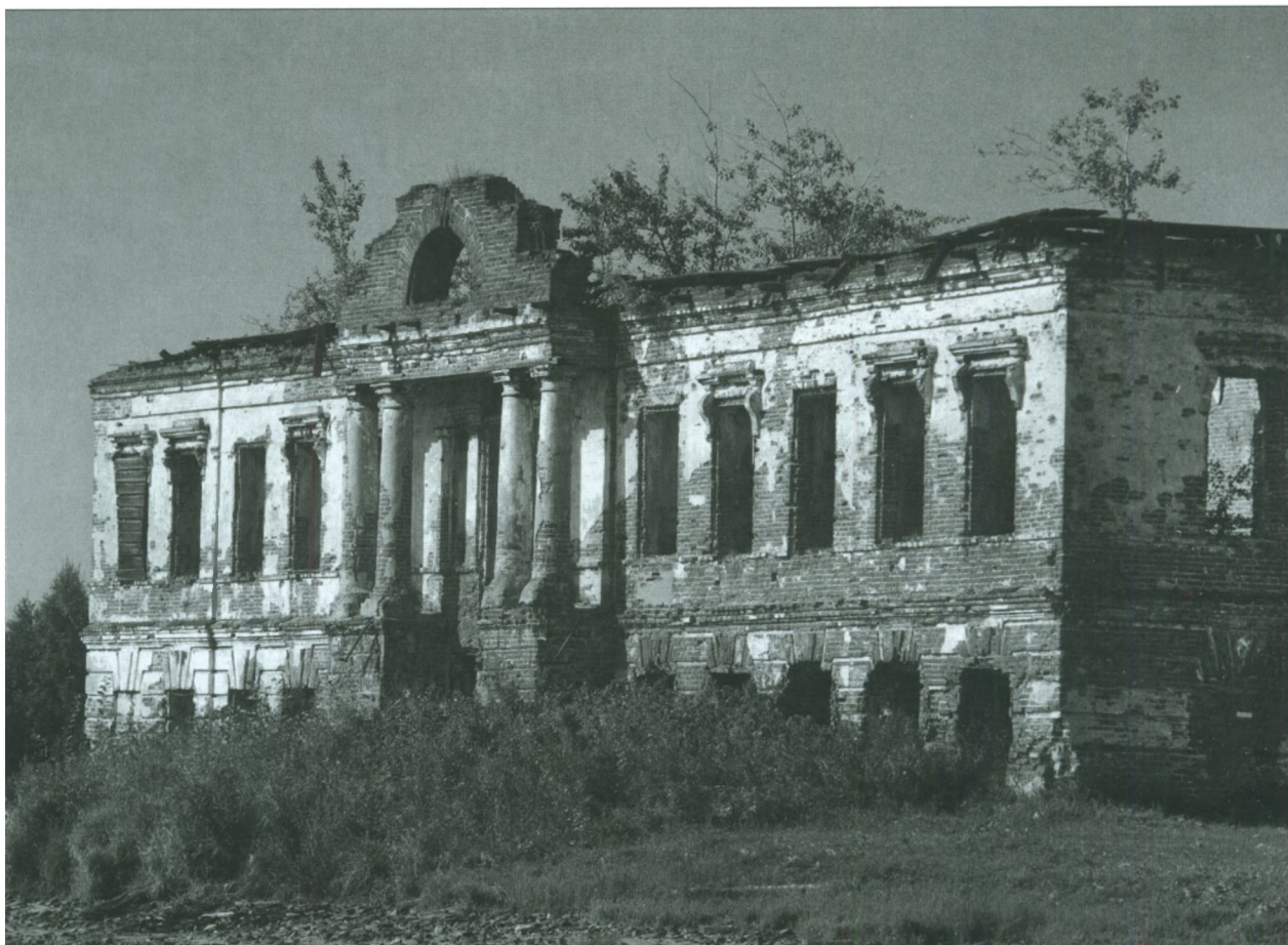
[37] Усолье. Дом Абамалек-Лазарева, вид с северо-запада. Usolye. Abamalek-Lazarev house, northwest view.
