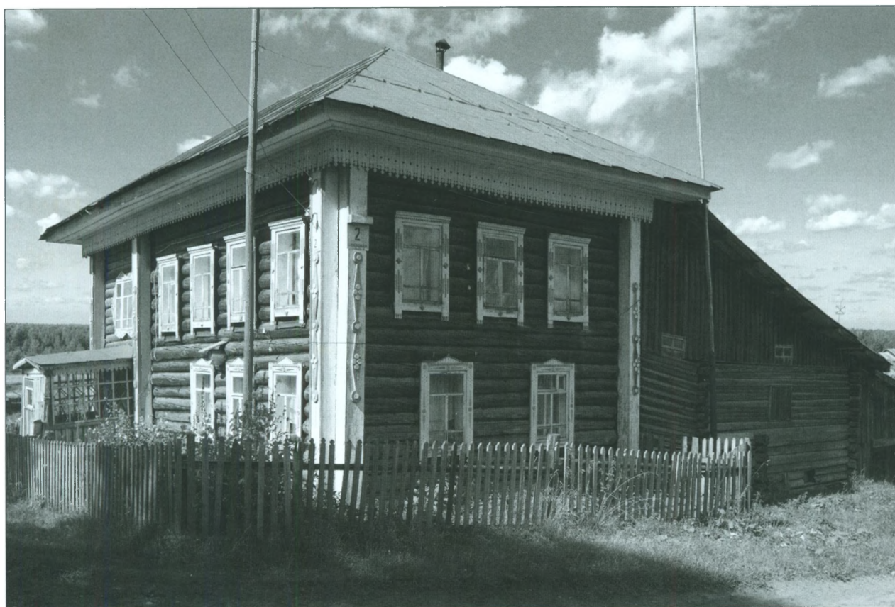
[111] Деревянный дом и сарай, улица Пятилетки, 13. Log house & barn, Piatiletka street 13.
