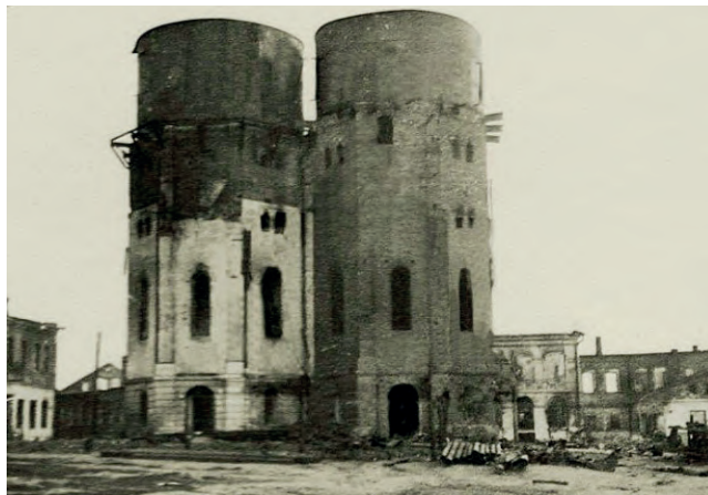
Водонапорные башни на южной стороне Могилевского рынка.
