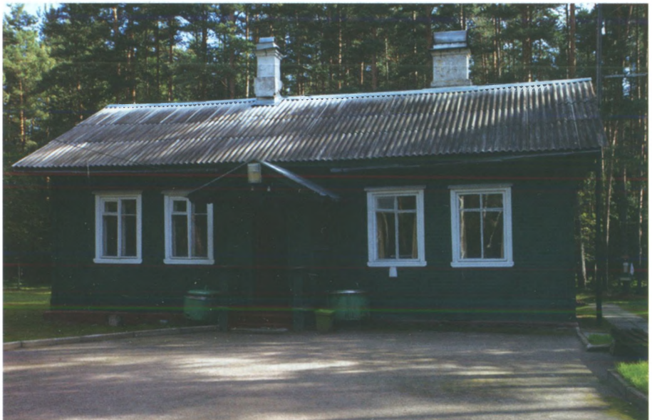
Бывшее караульное здание. Современный вид
