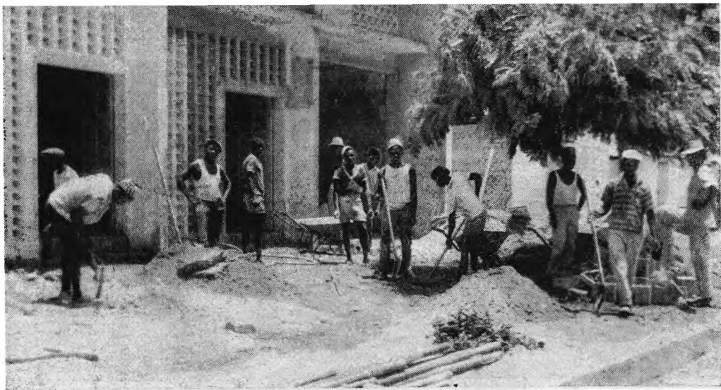
Гвинейцы на строительстве нового дома
