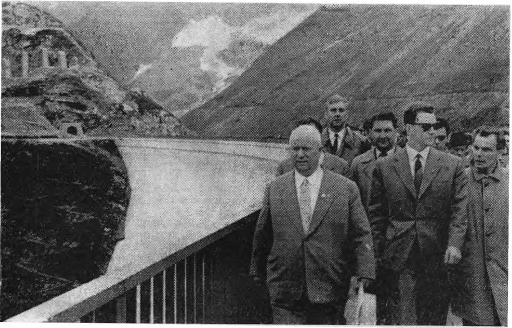
На плотине высокогорной гидроэлектростанции «Капрун»
