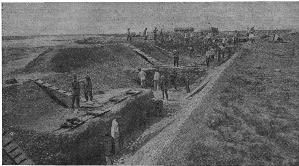
Начальные работы по прорытию канала (1928 г.).
