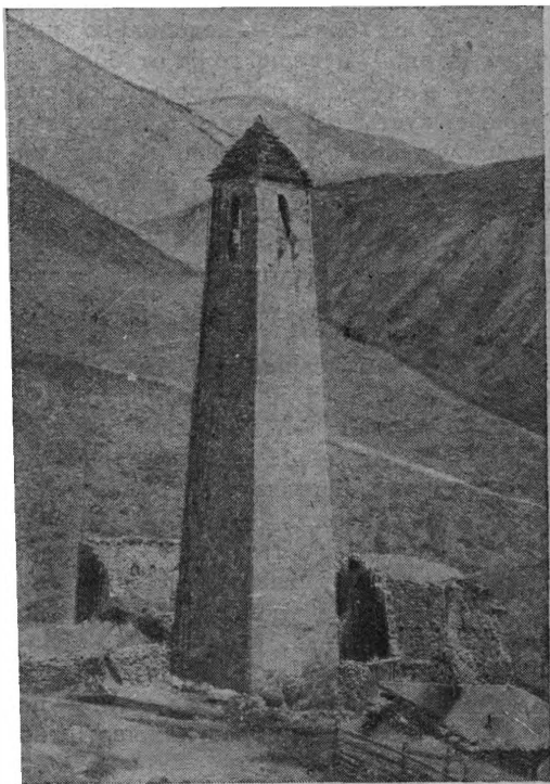
Горная Ингушетия. Развалины старинного укрепления и сторожевая башня в с. Могуч-Кала. В правом углу видна крыша современного жилья потомков быв. владельцев укрепления
