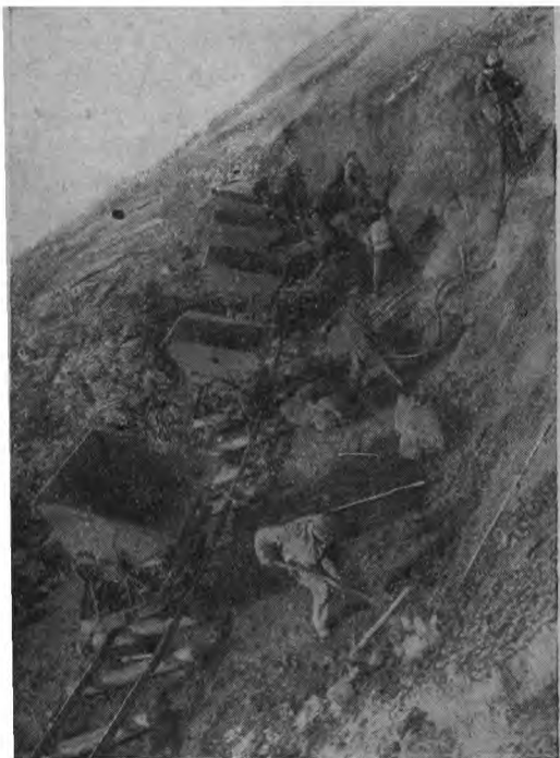
Вскрышные работы на горе.
