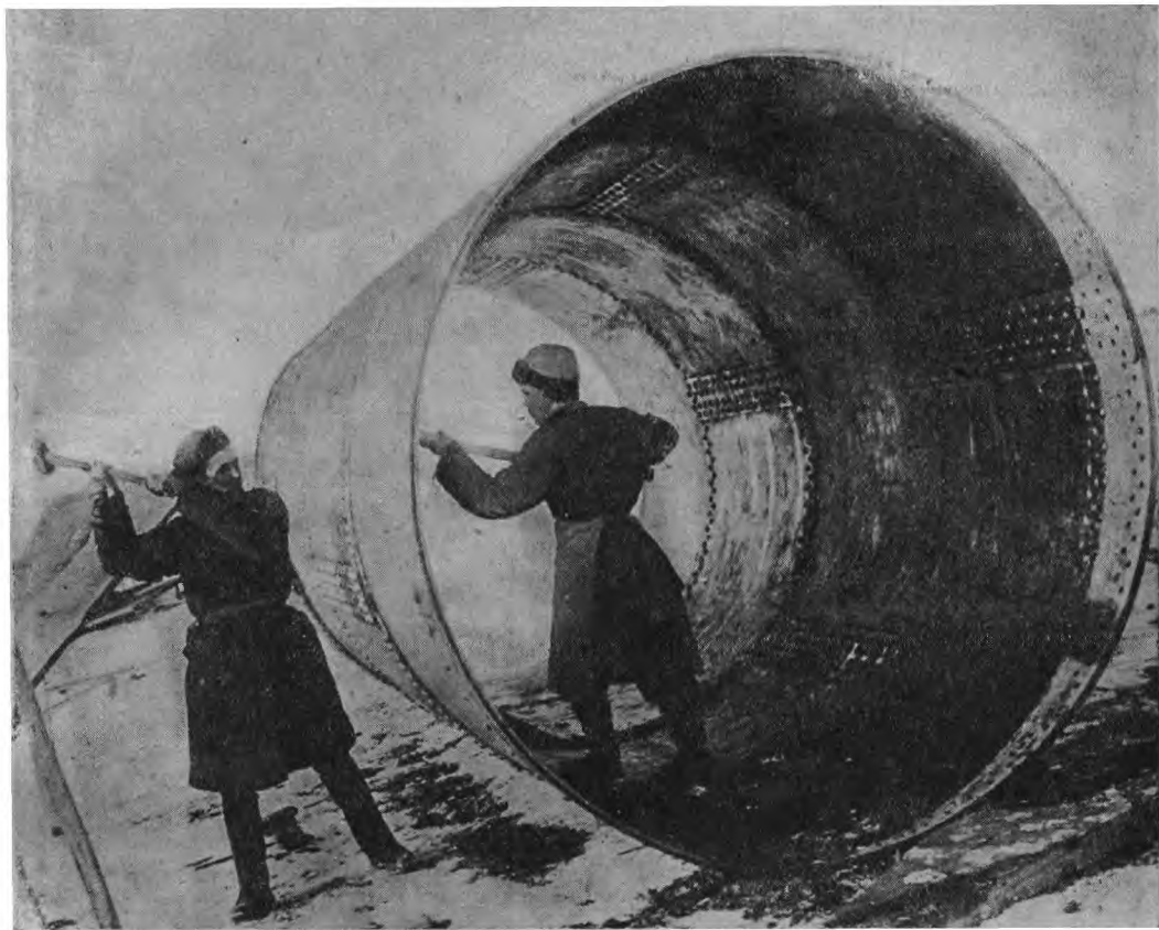
Клепка газовых труб для Коксохима
