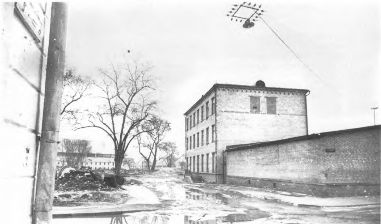
1979 г. Вид с северо-востока трехэтажного здания на месте часовни, от перекрестка Якиманского и Мароновского переулков
