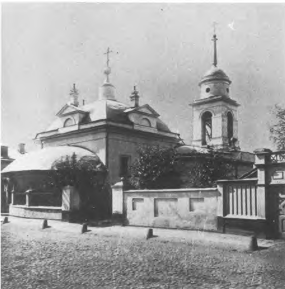
1881 г. Вид церкви Воскресения с северо-востока. Альбом Найденова, ч. 3, отд. 1, № 20
