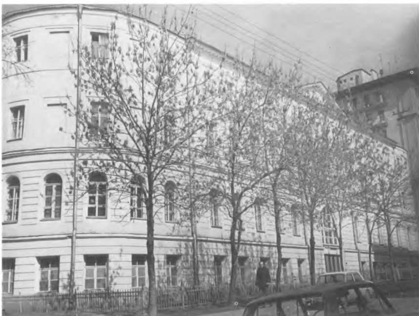
1979 г. Вид здания с переулка Садовских, с юга
