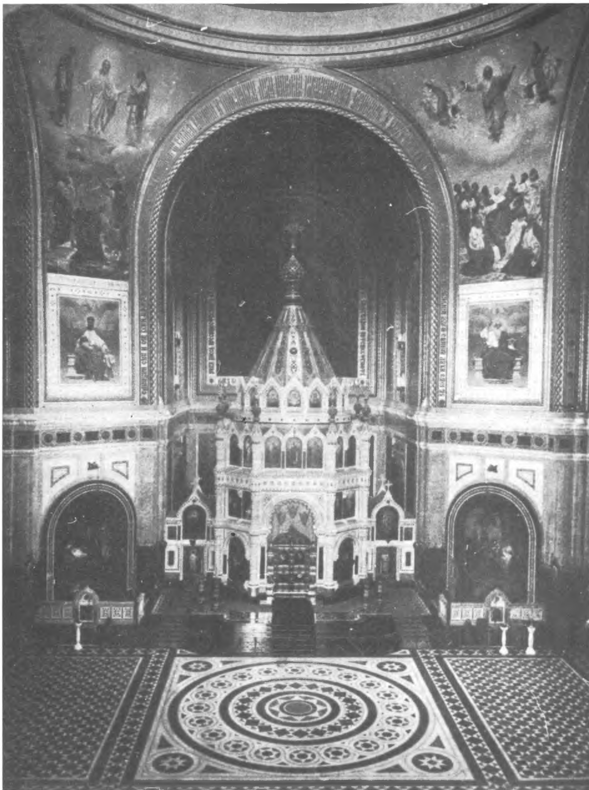
1912 г. Внутренний вид храма от западных хор 28
