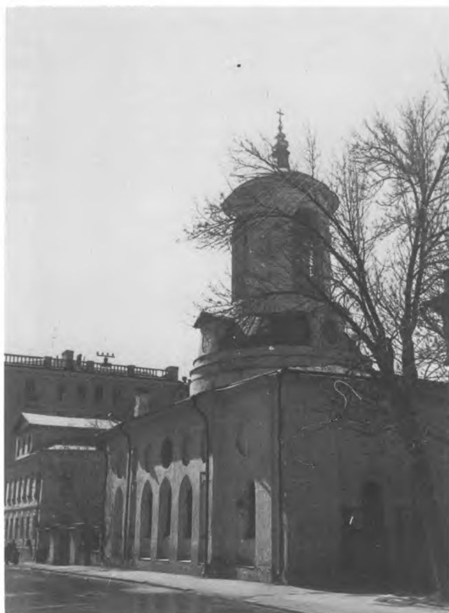
1979 г. Вид оттуда же (портик снесен, разрослись запущенные деревья)
