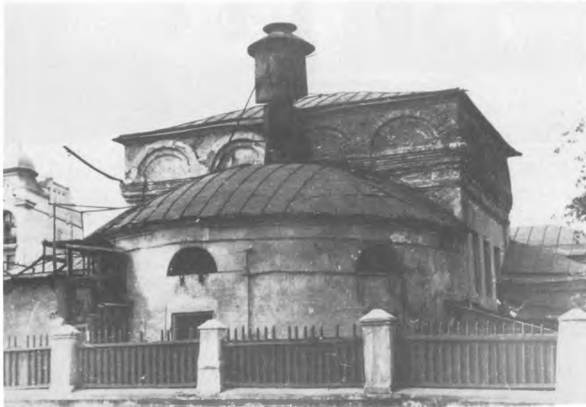
1965 г. Вид обезглавленного главного храма с востока
