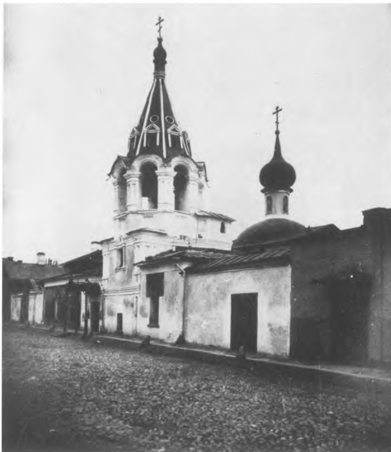
1881 г. Вид церкви св. ап. Филиппа с юго-запада. Альбом Найденова, ч. 3, отд. 1, № 16
