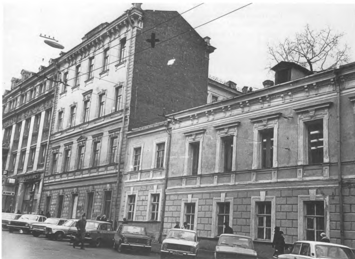
1979 г. Четырехэтажный корпус по Пушечной улице, где на четвертом этаже была церковь
