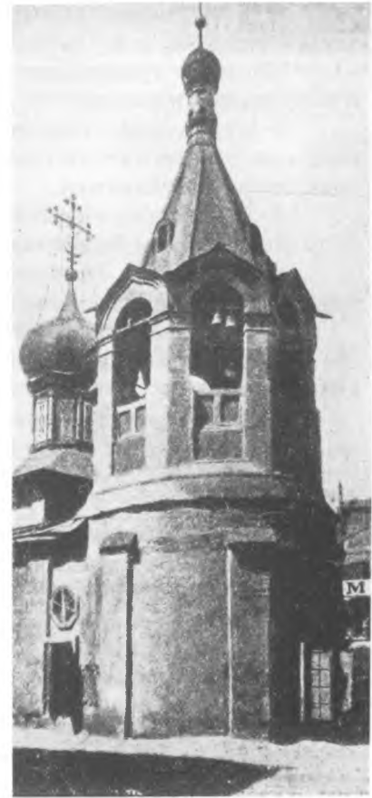
1913 г. Вид колокольни храма 47
