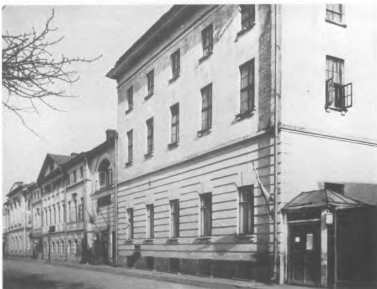
1910-е гг. Вид здания рабочего дома с запада, от Большого Харитоньевского переулкa 89
