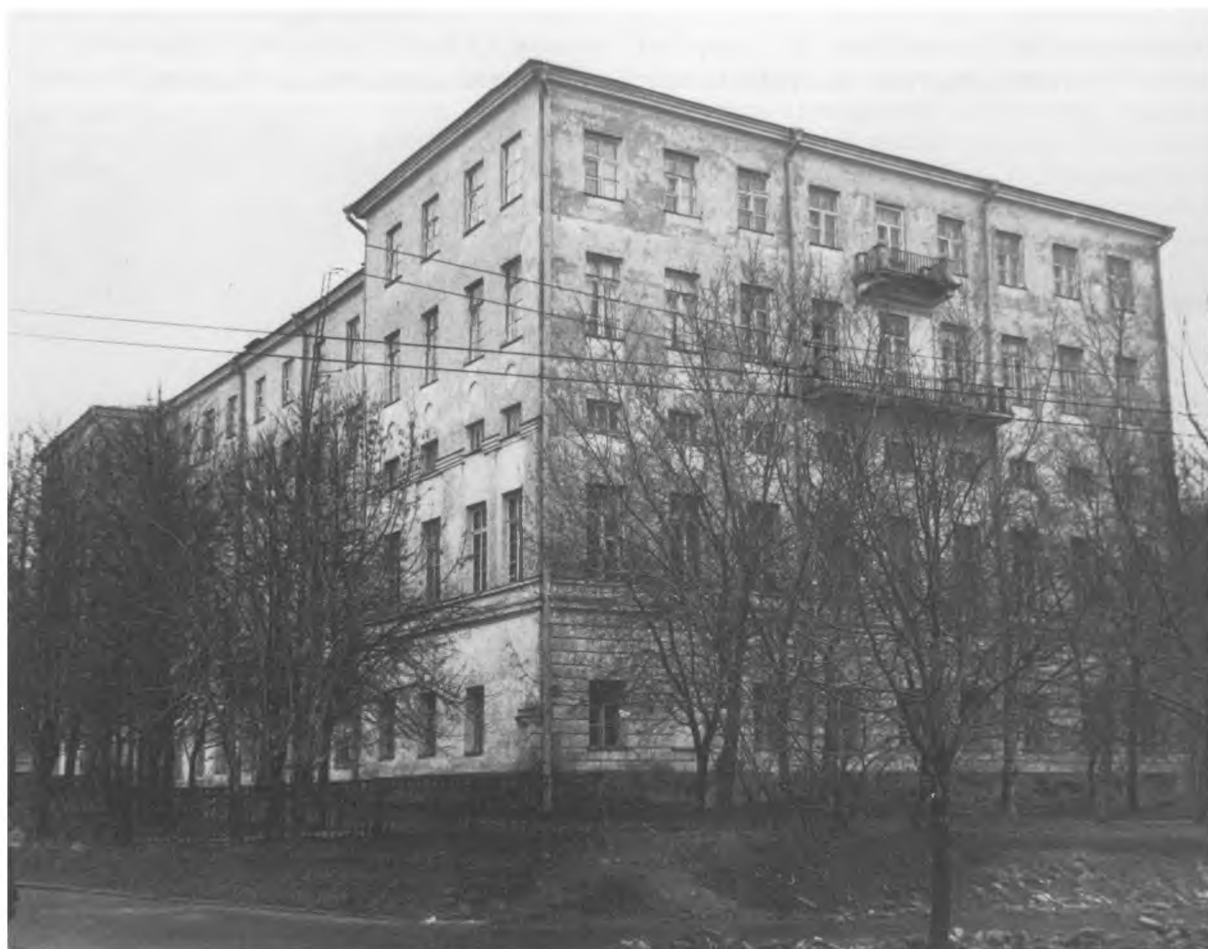
1979 г. Вид дома с Волхонки, с юга
