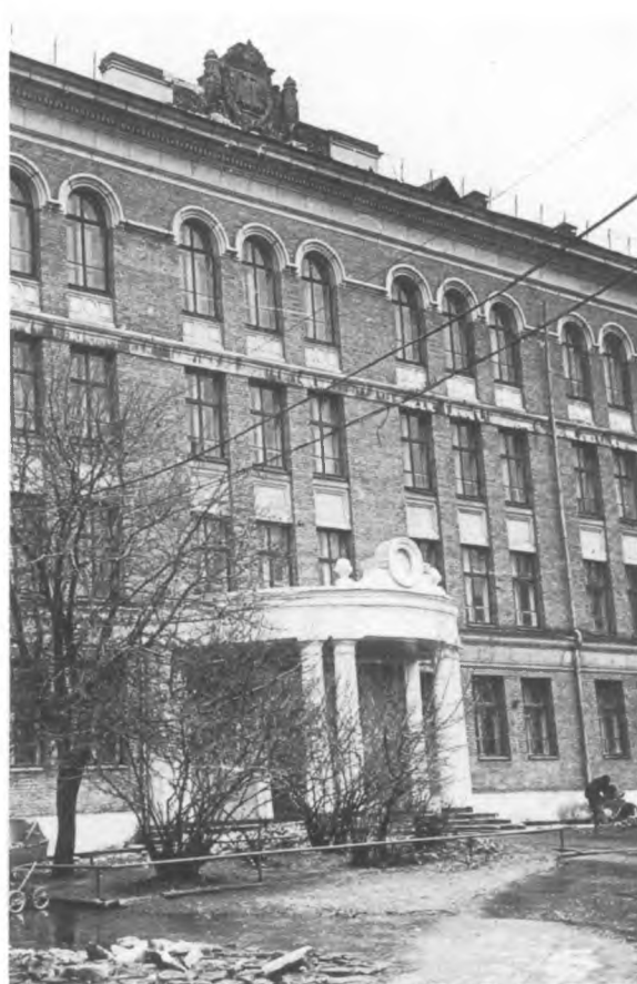
1979 г. Вид школы и площадки перед ней на месте храма — примерно оттуда же
