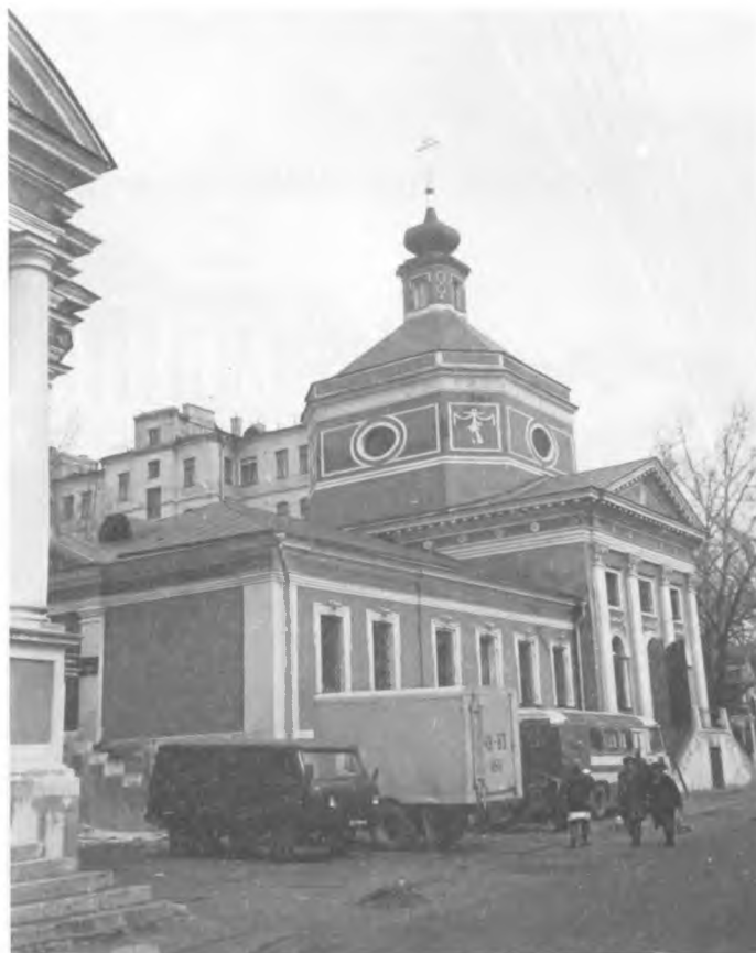
1979 г. Вид на церковь Животворящей Троицы оттуда же
