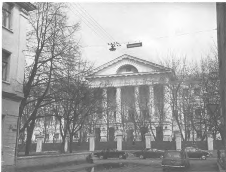
1979 г. Вид здания Филаретовского училища с запада, от Чудовского переулка (ныне пер. Стопани)
