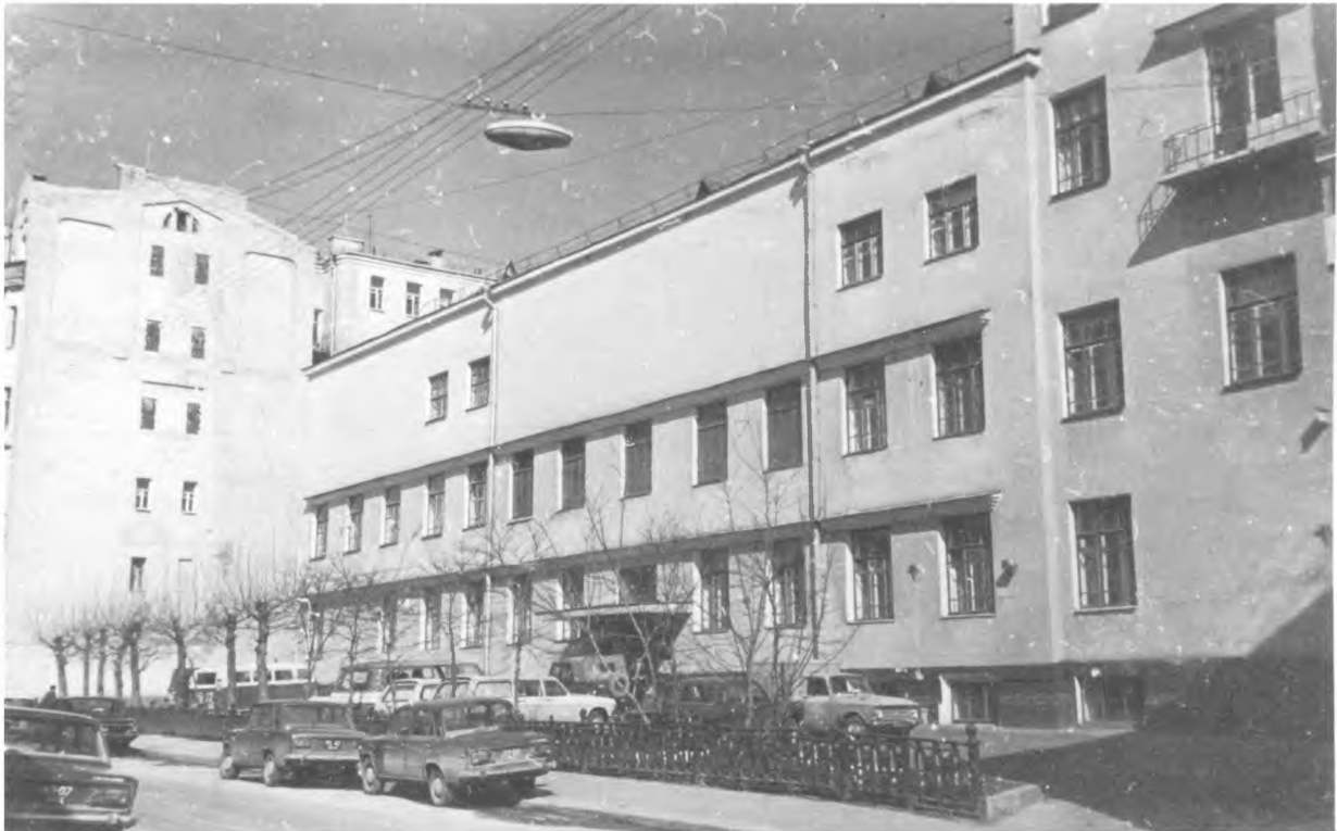
1979 г. Фасад дома, вид с юго-запада, от Лихова переулка — вся обработка уничтожена
