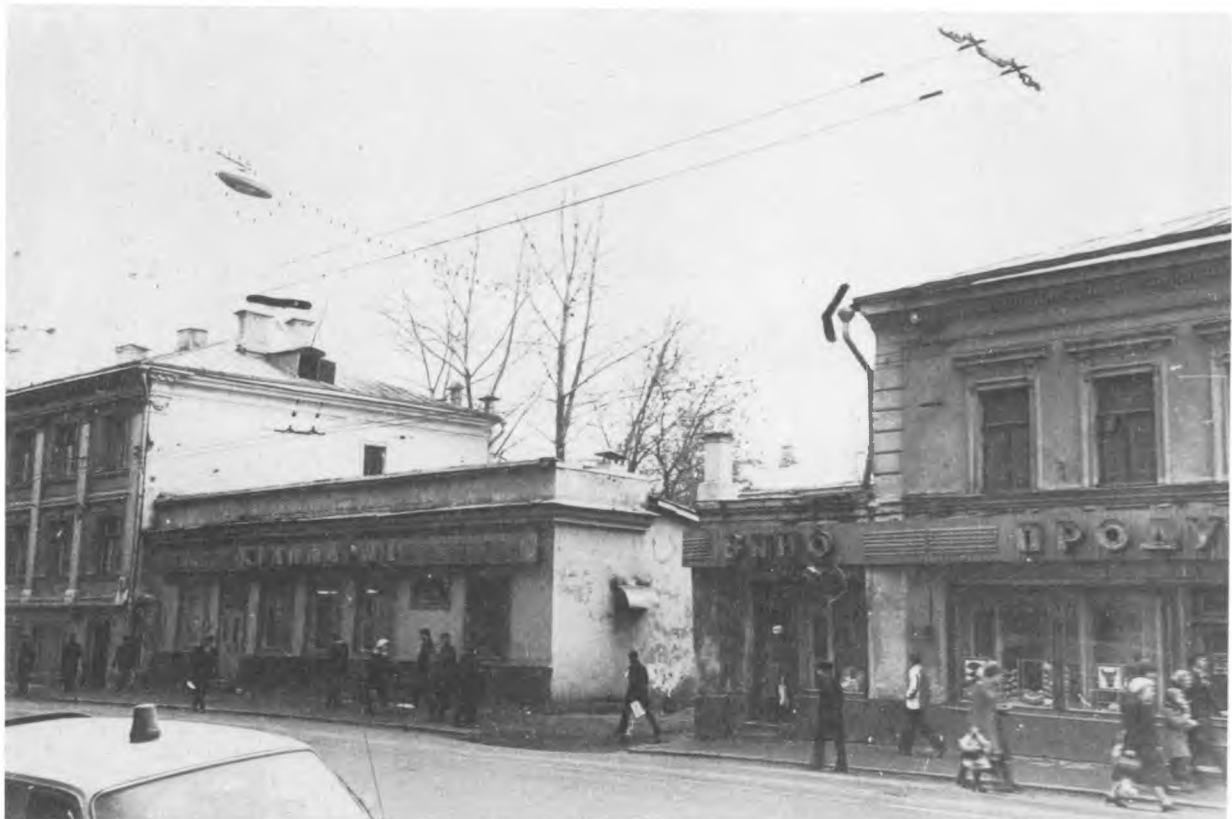
1979 г. Вид оттуда же (привязка: стена дома на заднем плане слева и угол дома справа)
