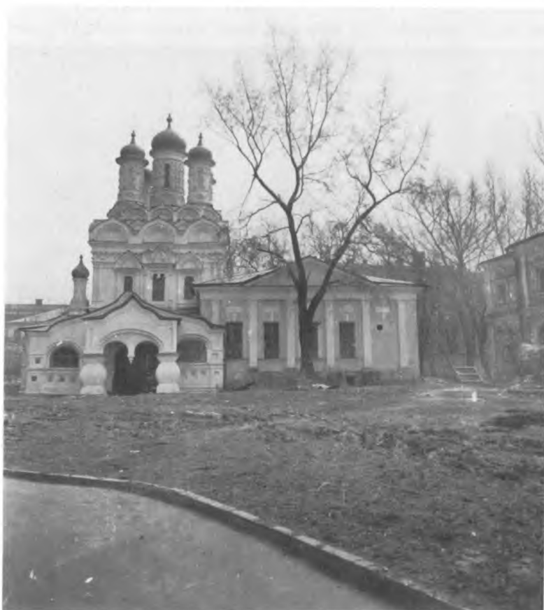
1979 г. Вид отсюда же — колокольня, однако, разрушена полностью
