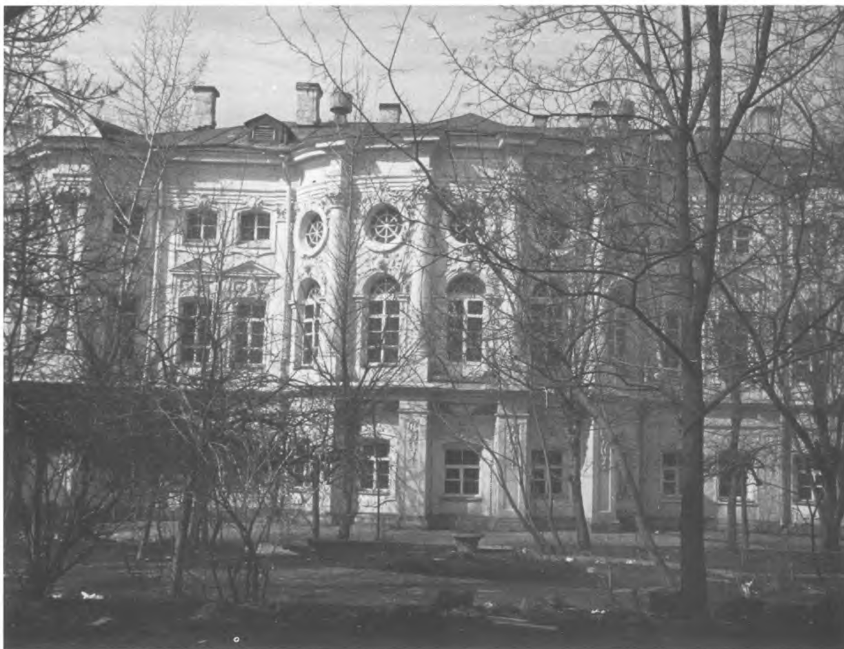
1979 г. Дворовой фасад здания, в центре его — овалный зал, где находилась разоренная церковь Благовещения
