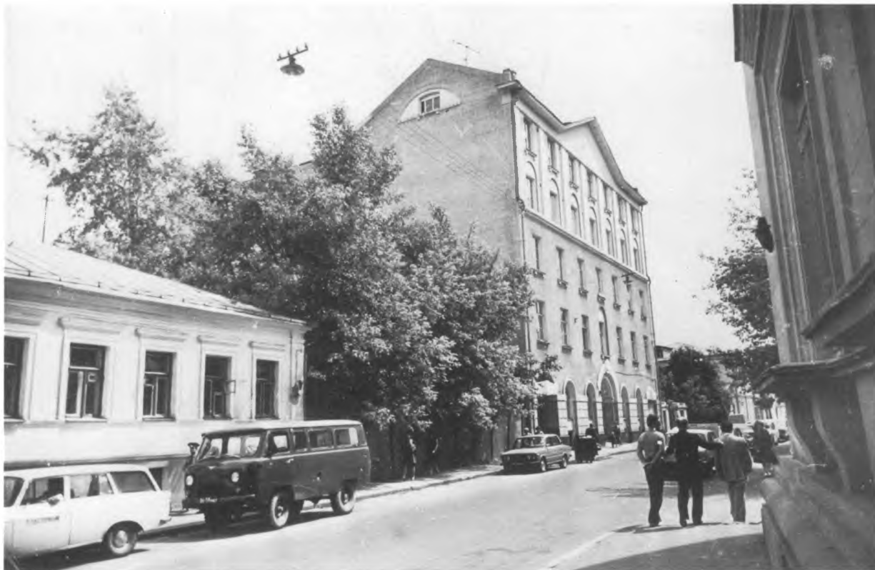
1979 г. Вид дома № 33 по Старомонетному переулку, с северо-запада
