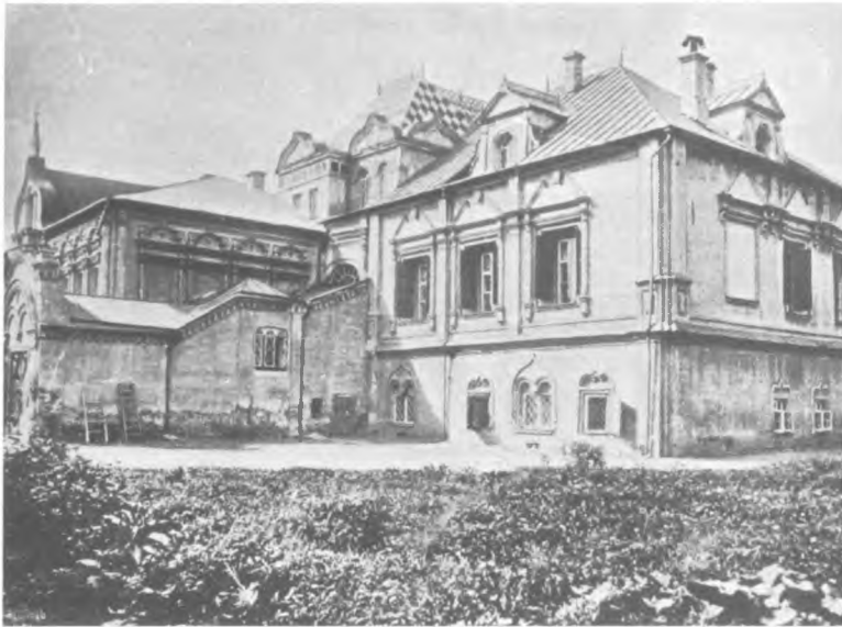
1903 г. Вид здания (бывш. дома кн. Юсуповой граф. Сумароковой- Эльстон) с юго-востока 88
