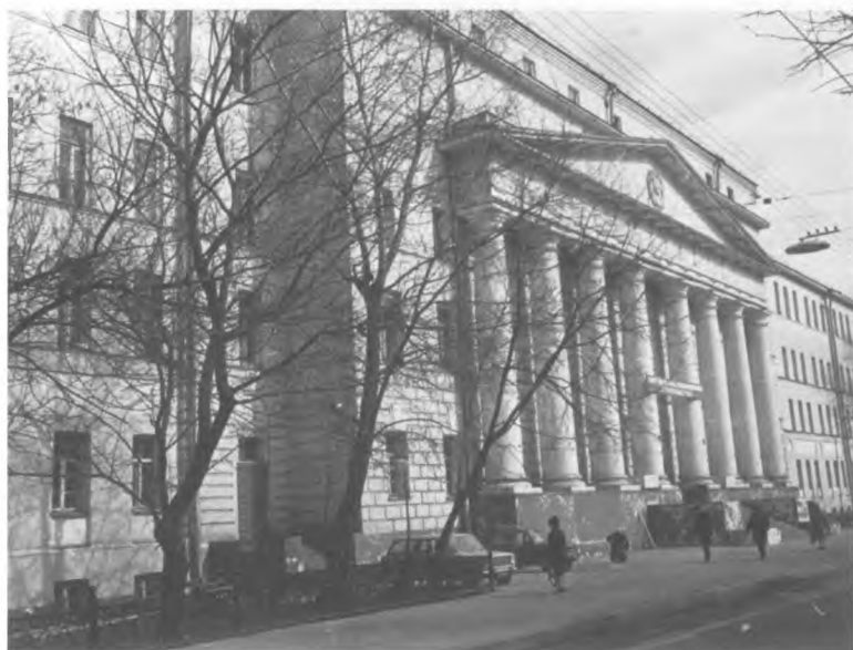
1979 г. Вид фасада надстроенного здания вблизи
