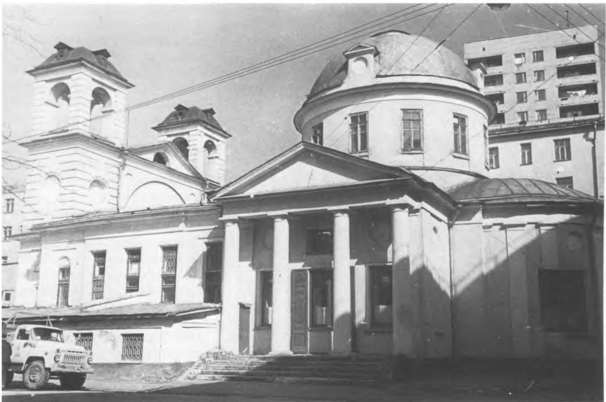
1979 г. Вид с юго-востока
