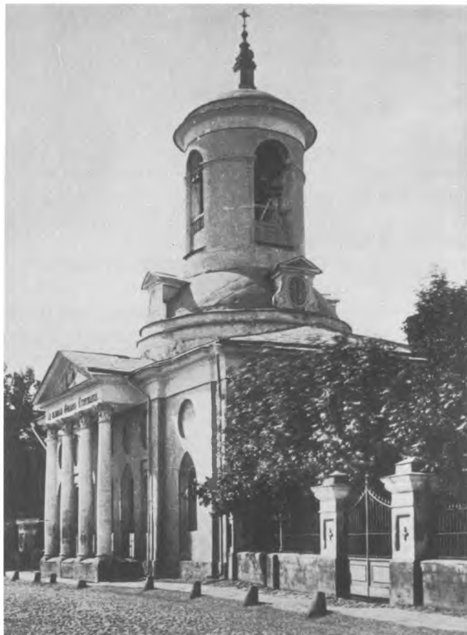
1881 г. Вид церкви Феодора Стратилата с юго-востока. Альбом Найденова, ч. 2, № 35А
