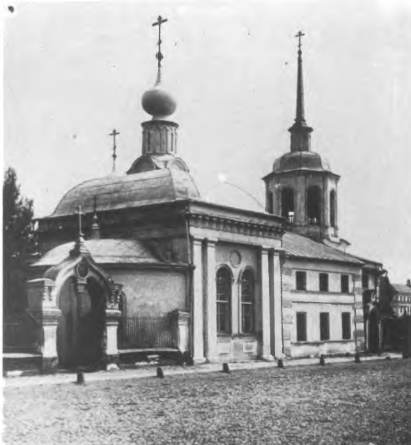
1881 г. Вид церкви Успения Божией Матери с северо-востока. Альбом Найденова, ч. 3, отд. 1, № 14
