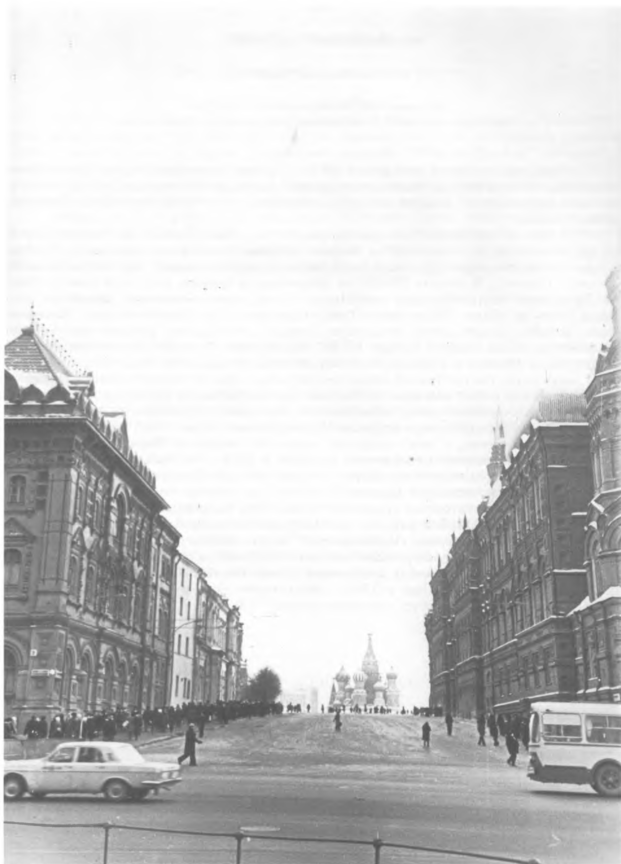
1979 г. Вид отсюда же, с северо-запада. Все ворота разрушены
