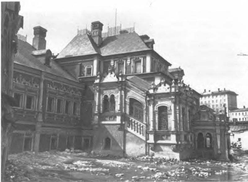
1979 г. Вид здания с северо-запада, со двора
