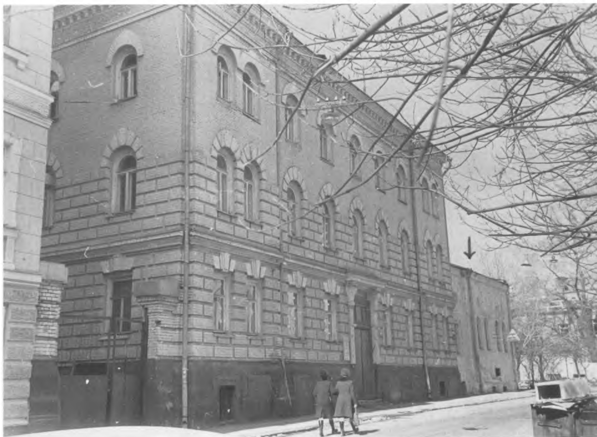
1979 г. Вид здания приюта и одноэтажной пристройки за ним, в которой помещалась церковь Александра Невского, с улицы Писемского
