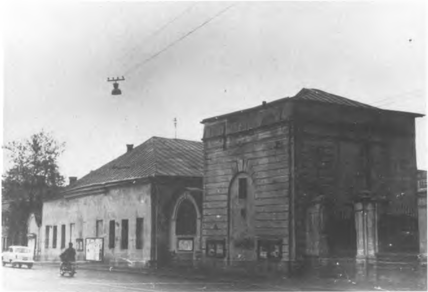
1965 г. Вид разобранной до первого яруса колокольни и трапезной храма с юго-запада
