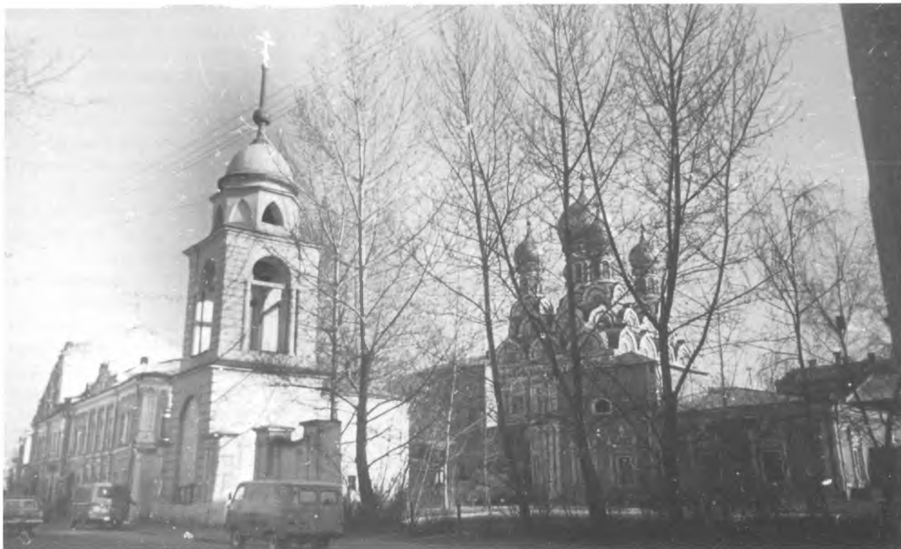
1979 г. Вид храма с колокольней от улицы Осипенко, с северо-запада
