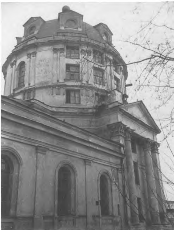
1979 г. Вид центральной ротонды со двора, с юго-запада
