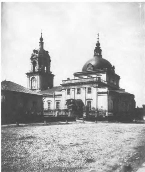
1881 г. Вид церкви Космы и Дамиана Нового с юго-востока. Альбом Найденова, ч. 3, отд. 1, № 57
