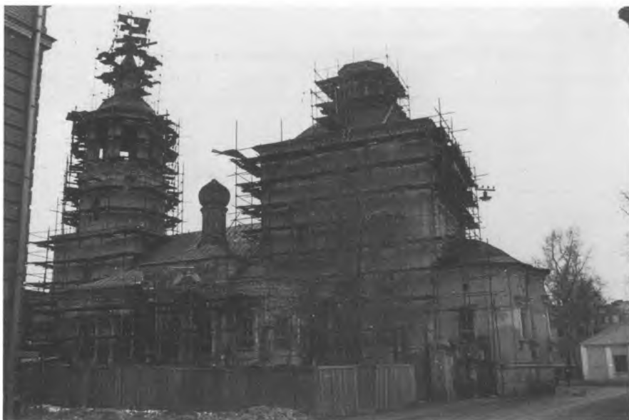
1983 г. Вид с юго-востока
