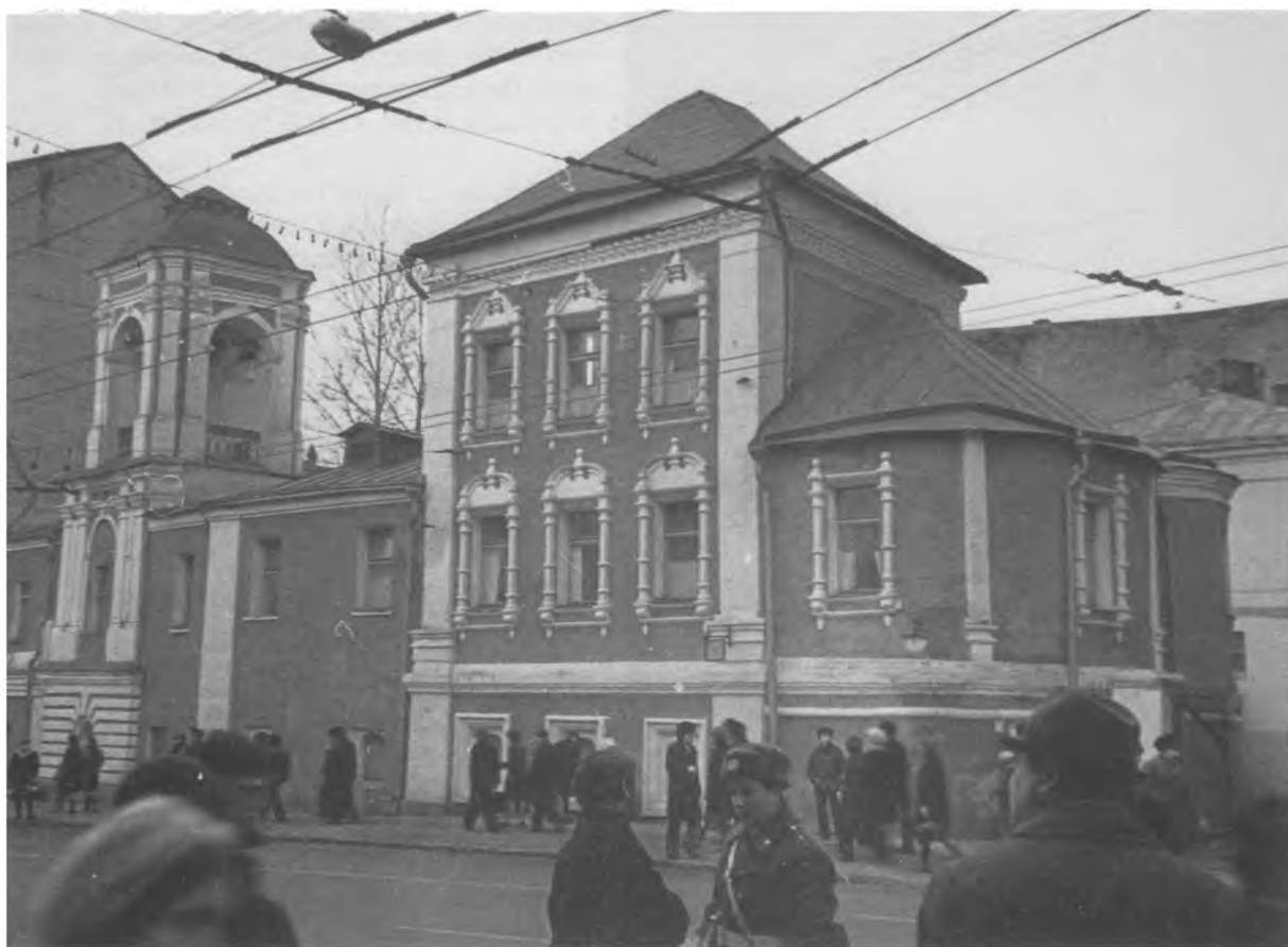
1979 г. Вид с юго-востока
