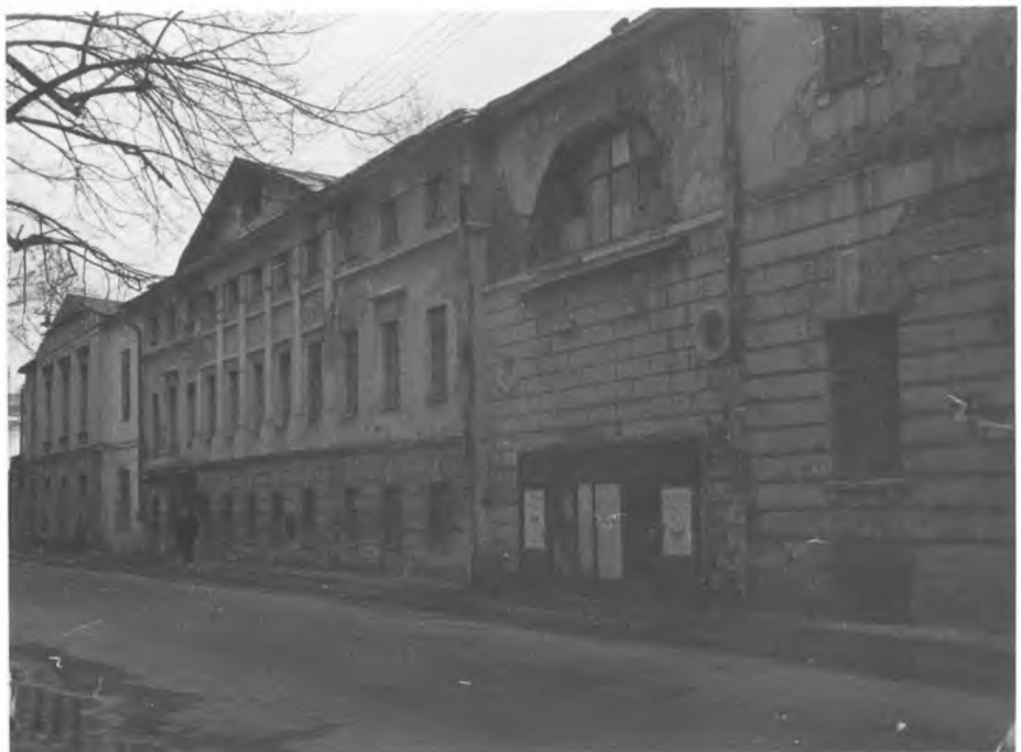
1979 г. Вид здания примерно оттуда же
