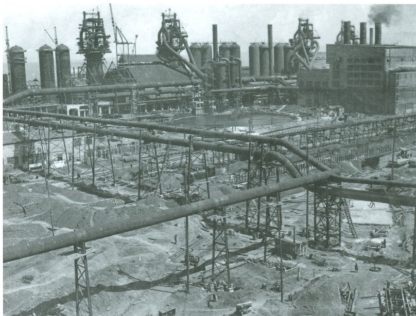
Магнитострой. Строительство первой очереди доменного цеха
