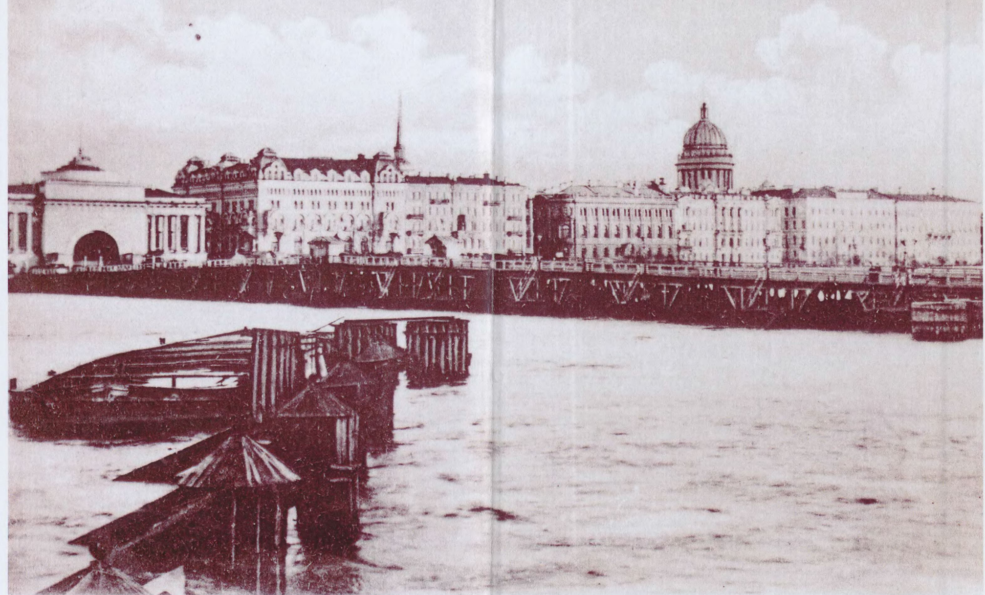
Дворцовый мостъ и Адмиралтейская набережная. Pont de Palais et quai de l'Amirauté.
