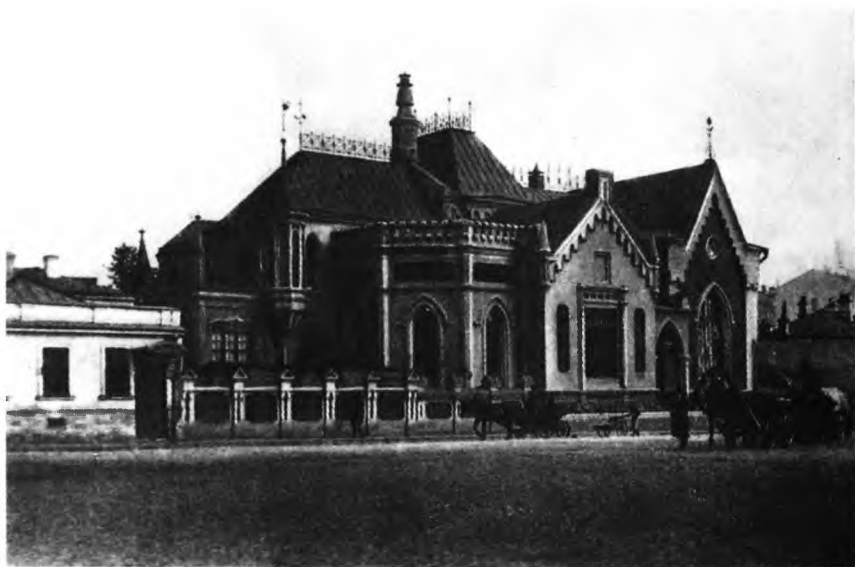
27. Дом Мазуриных на Собачьей площадке. Конец XIX в. Открытка
