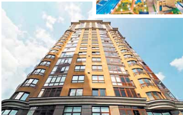
Дом в Большом Тишинском переулке
