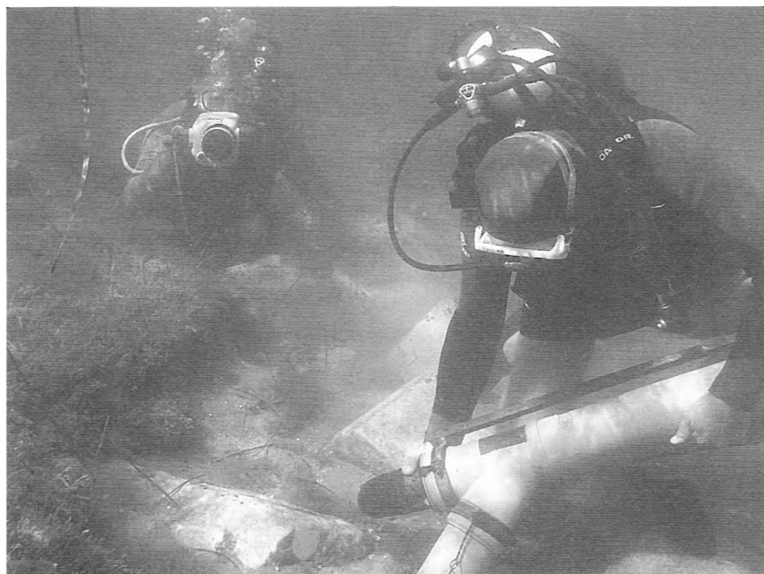
Рис. 6. Работа водолаза грунтососом
